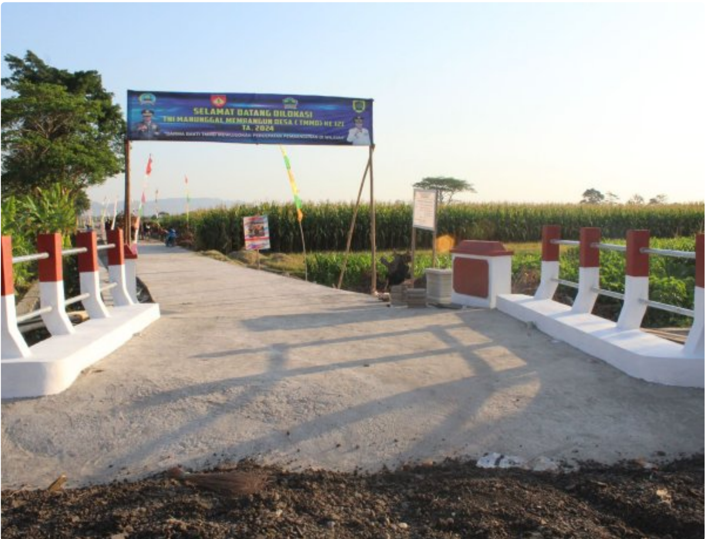
Dandim Klaten Berharap Warga Merawat Jembatan TMMD
