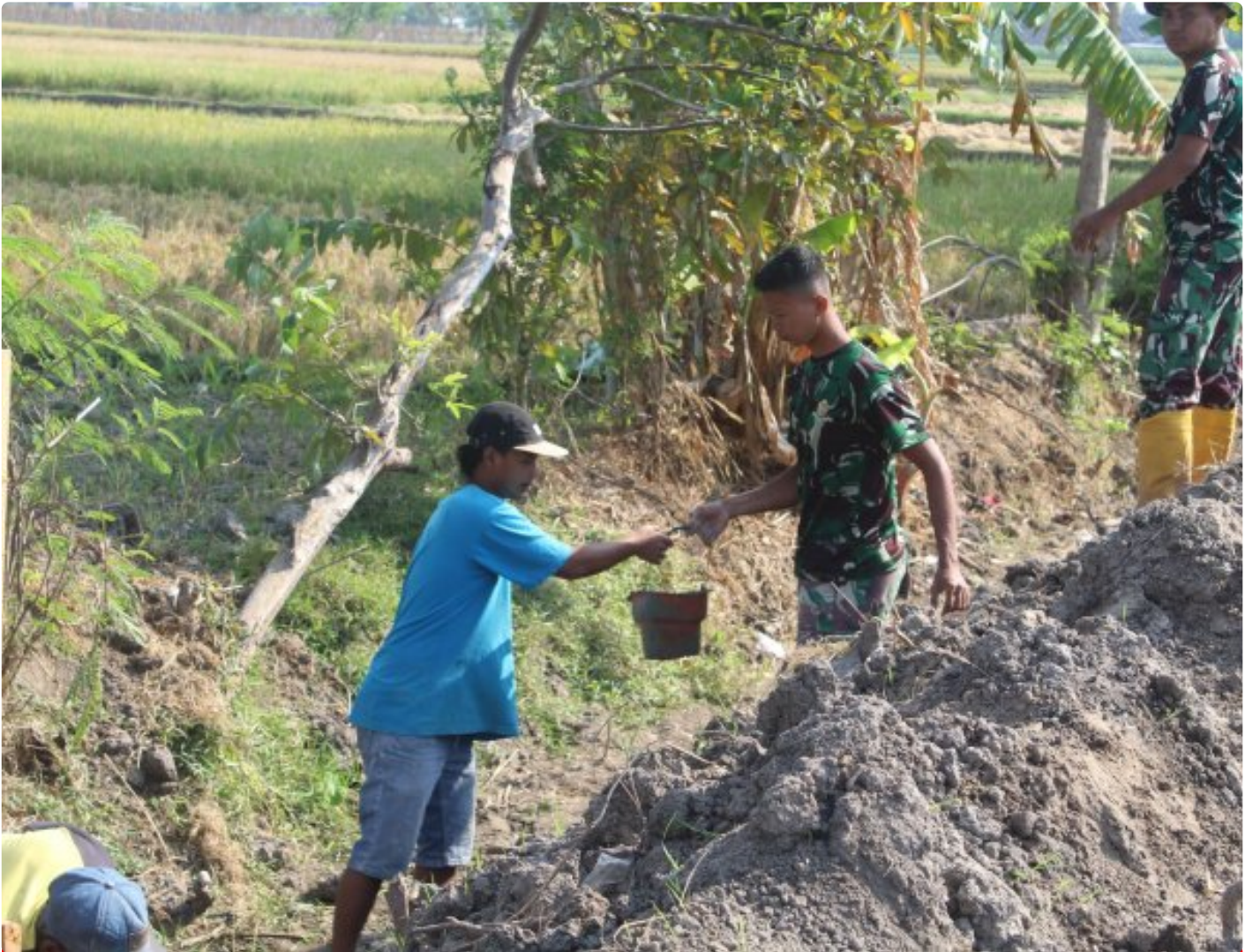
Pembuatan Talud TMMD Reg 121 Sudah Mulai Terlihat Hasilnya
